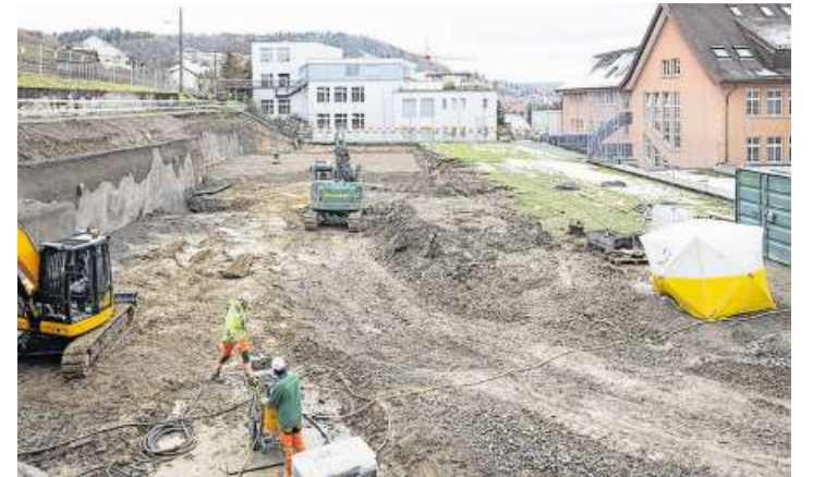
Blick auf die Baustelle: Hier entsteht das neue Oberstufenschulhaus.
